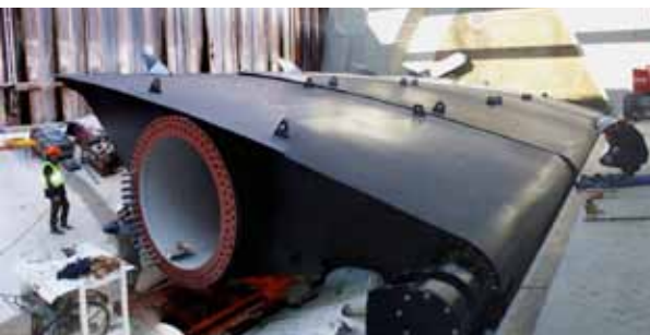
pose de clapet
