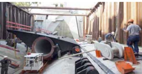
pose de clapet
