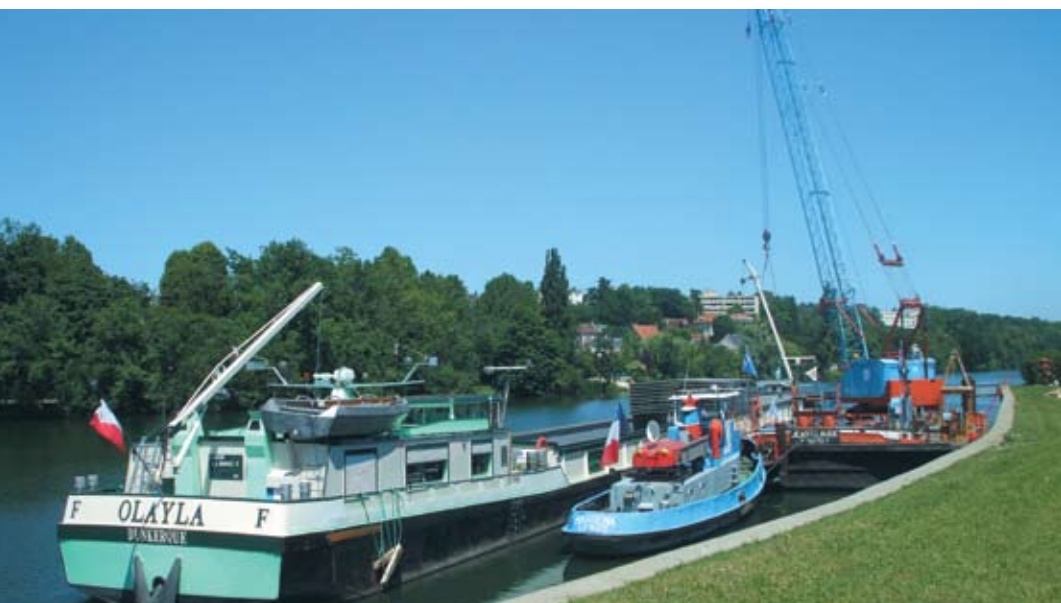
Les premiers travaux : livraison des palplanches par voie d'eau.
