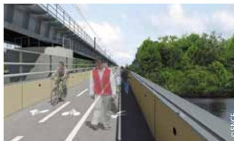
Dans le cadre du projet de prolongement du RER E (EOLÉ) à l'ouest, la Communauté d'agglomération a porté la réalisation d'une liaison douce entre Nanterre et Bezons au moyen d'une passerelle en encorbellement au nouveau pont ferroviaire d'EOLÉ.
